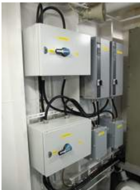
Sistema modulare composto da inverter, filtro e bypass elettromeccanico
