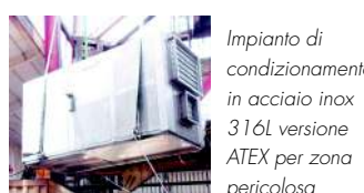
Impianto di condizionamento in acciaio inox 316L versione ATEX per zona pericolosa
